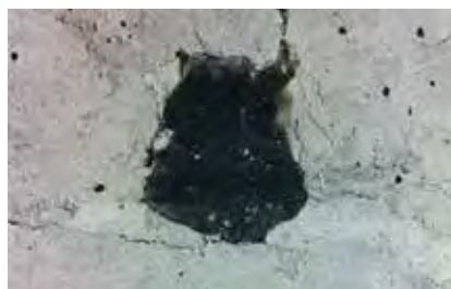
Nhìn gần của mặt cắt bê tông thể hiện sự trương nở của băng cản nước PENEBAR™ SW .
