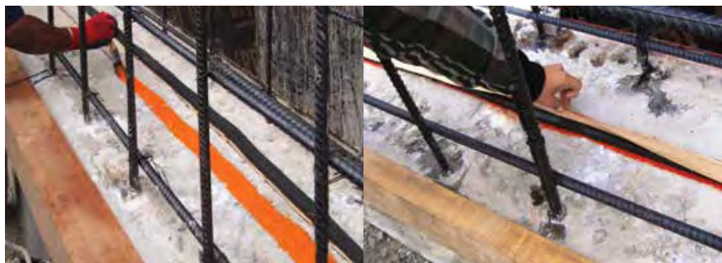
Xây dựng trên nền móng khô: Sunway Nexus, Kota Damansara, Petaling Jaya, Malaysia Đây là tổ hợp văn phòng cho thuê, thương mại và nhà ở, gồm 20 tầng cho văn phòng và ở, 2 tầng hầm cho bãi xe. PENETRON ADMIX® được dùng để chống thấm cho 4,800 m 3 (6,300 yd 3 ) bê tông tầng hầm và 1,100 m (3,600 feet) PENEBAK™ SW-55 được dùng cho mỗi nổi thi công.
